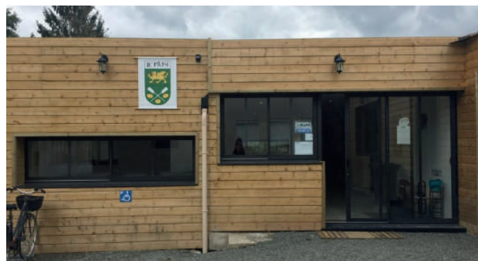
L'entrée de l'espace de coworking. (So'Work, usage réservé)
